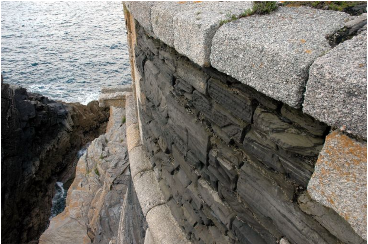
Vue de la batterie de Cornouaille : détail du parapet. Encadrement des créneaux, et cordon en granite ; remplissage en moellons de schiste
