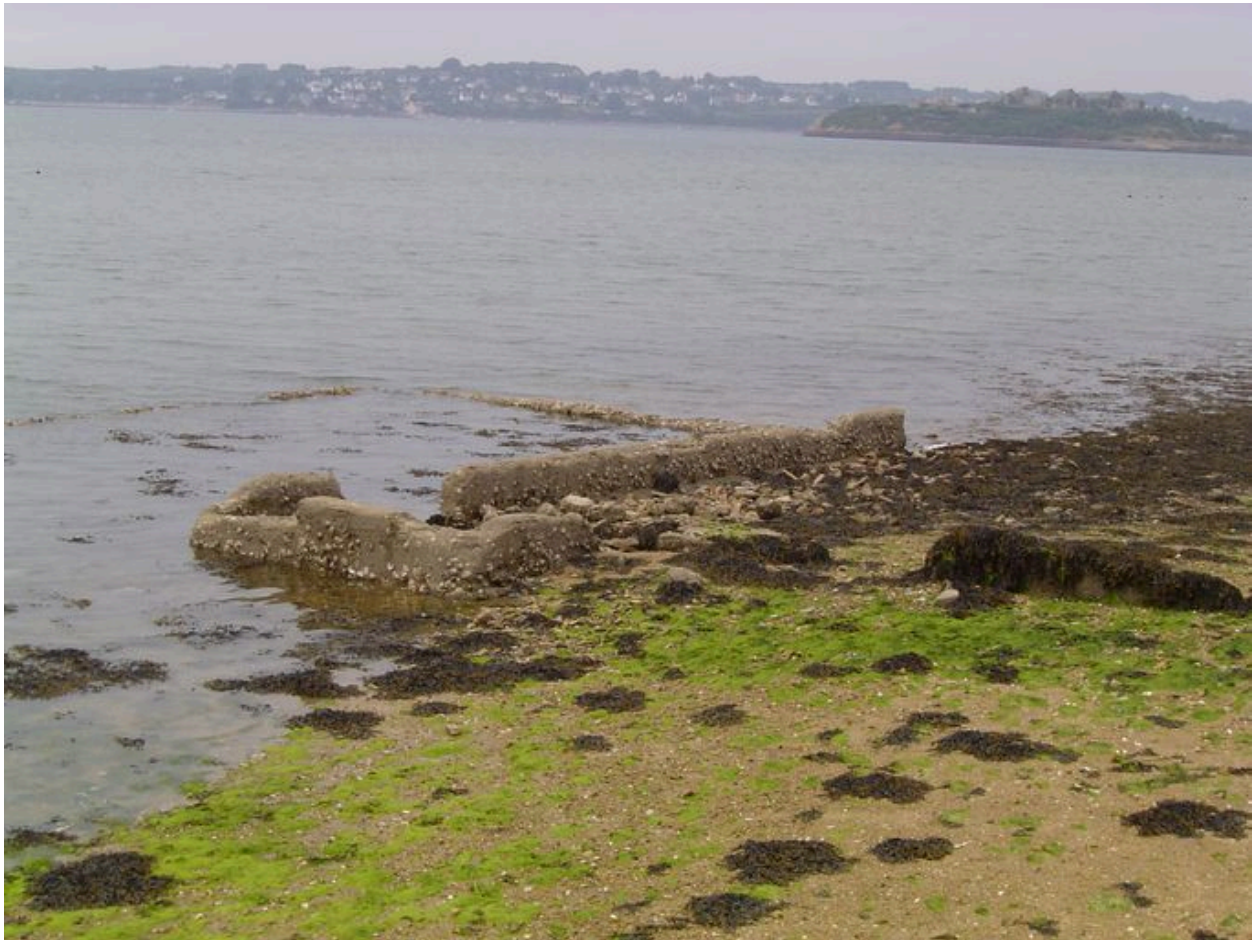
Bassin de décantation à huîtres
