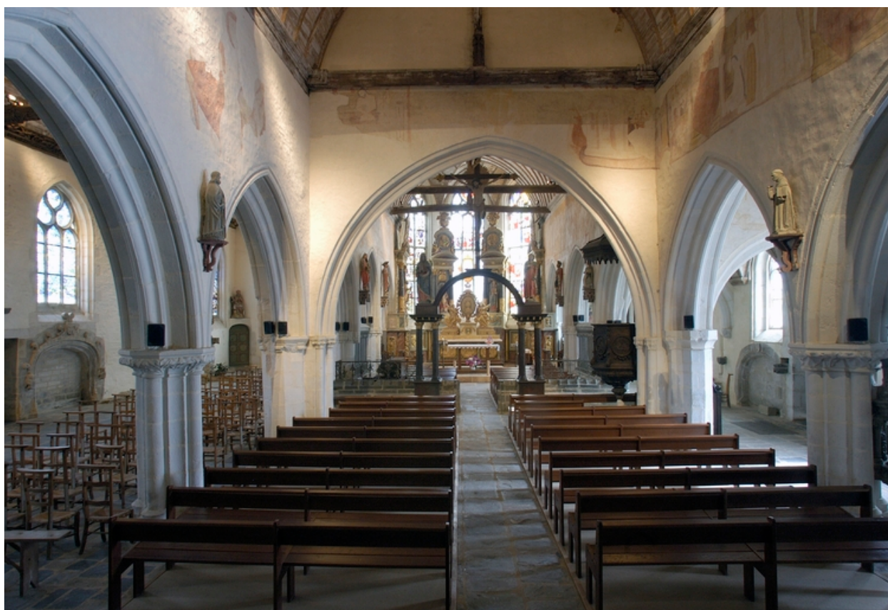
Vue depuis le bas de la nef vers le choeur
