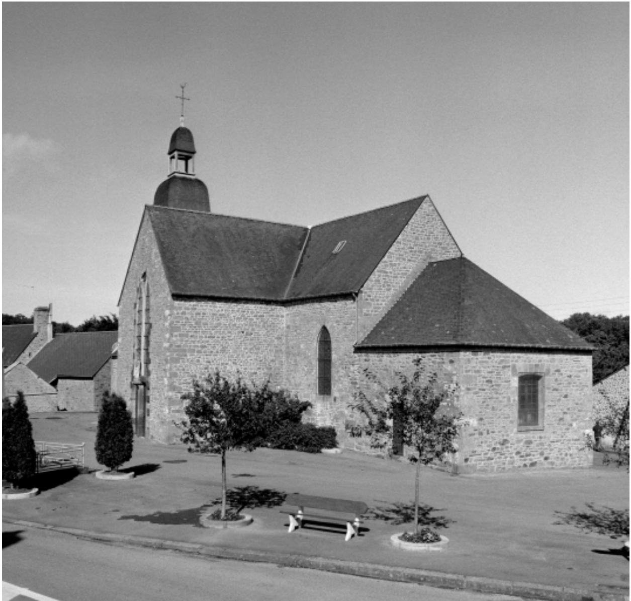
Elévation Est : vue générale
