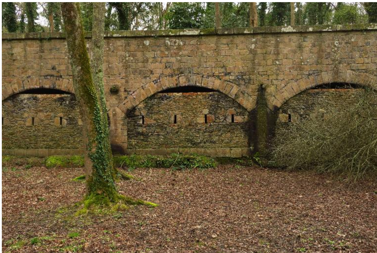
Le Palais, enceinte urbaine, galerie de contrescarpe, casemates.
