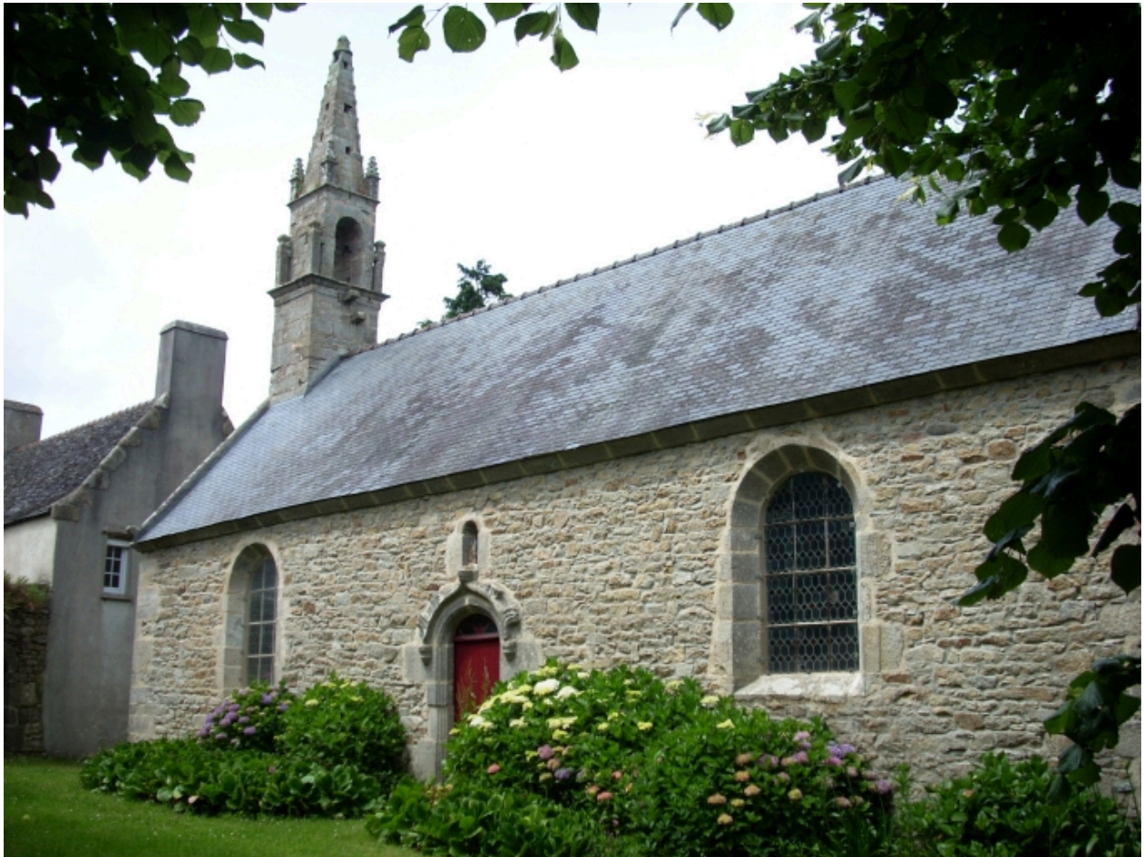
Plouguerneau, chapelle Saint-Laurent : vue générale sud
