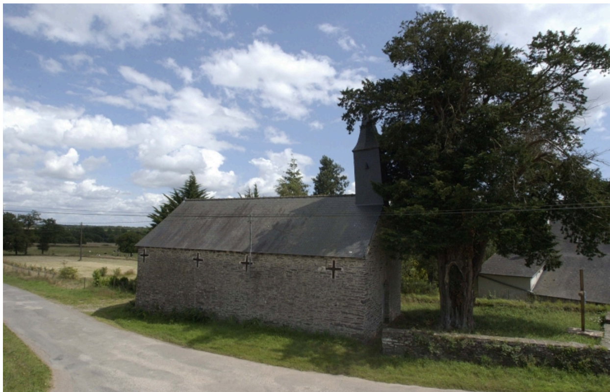
Vue de situation nord-ouest
