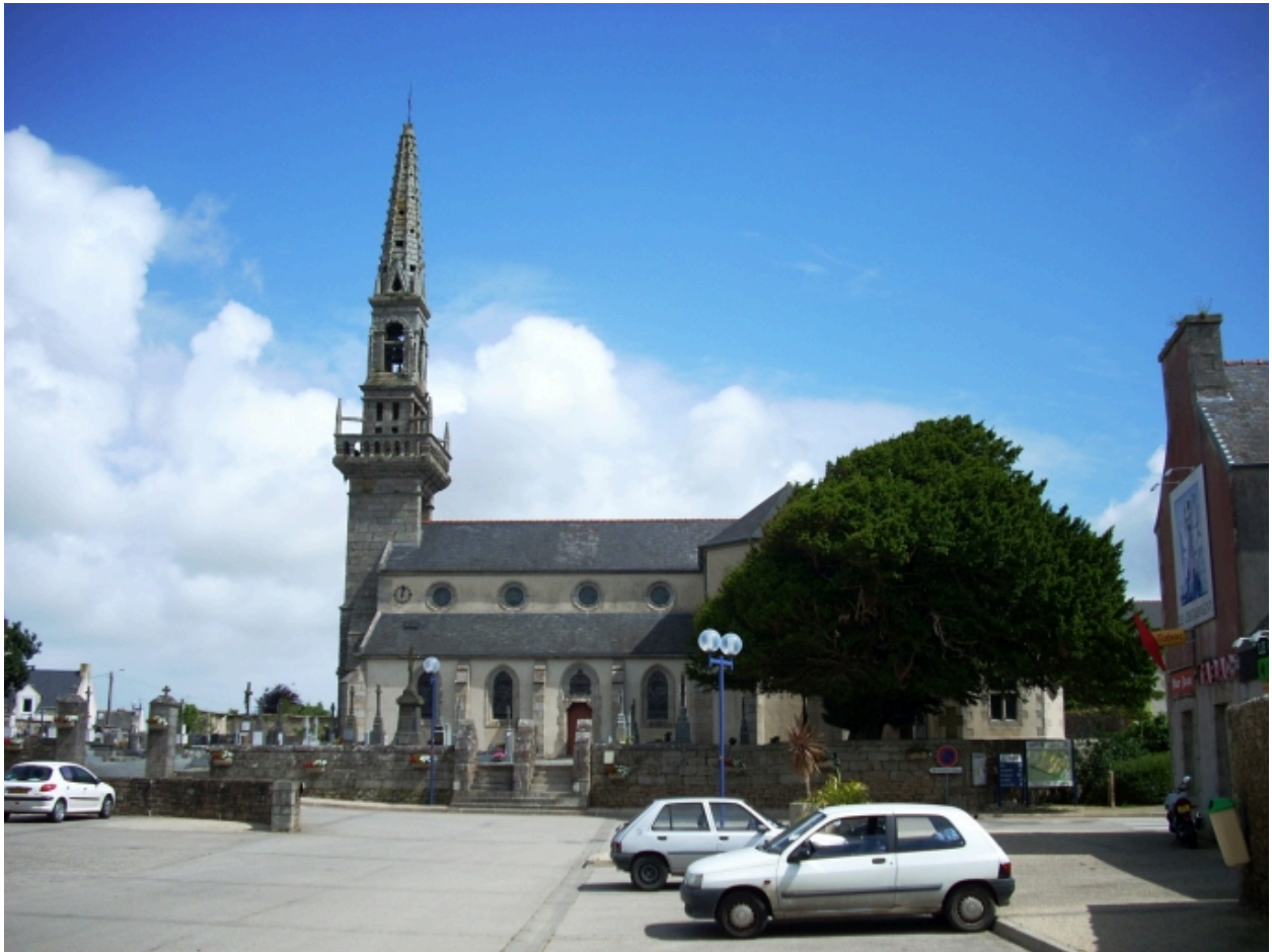
Kernilis, église paroissiale : élévation sud
