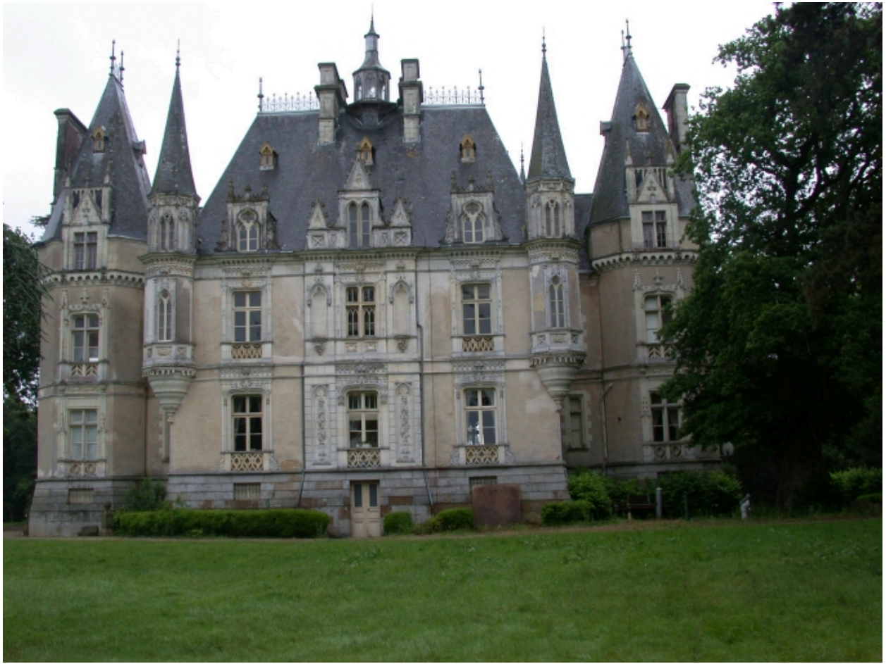
Vue générale de la façade arrière
