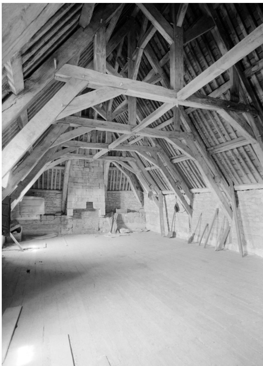
Charpente du grenier de l'aile ouest, état en 1967
