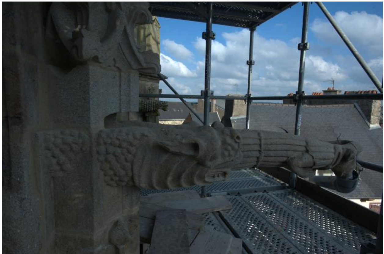
Portail nord. vue de l'échafaudage de restauration
