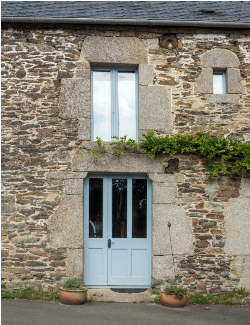
Logis est, élévation sud-est, vue générale de la porte d'entrée et de l'ouverture (surbaissée) du grenier
