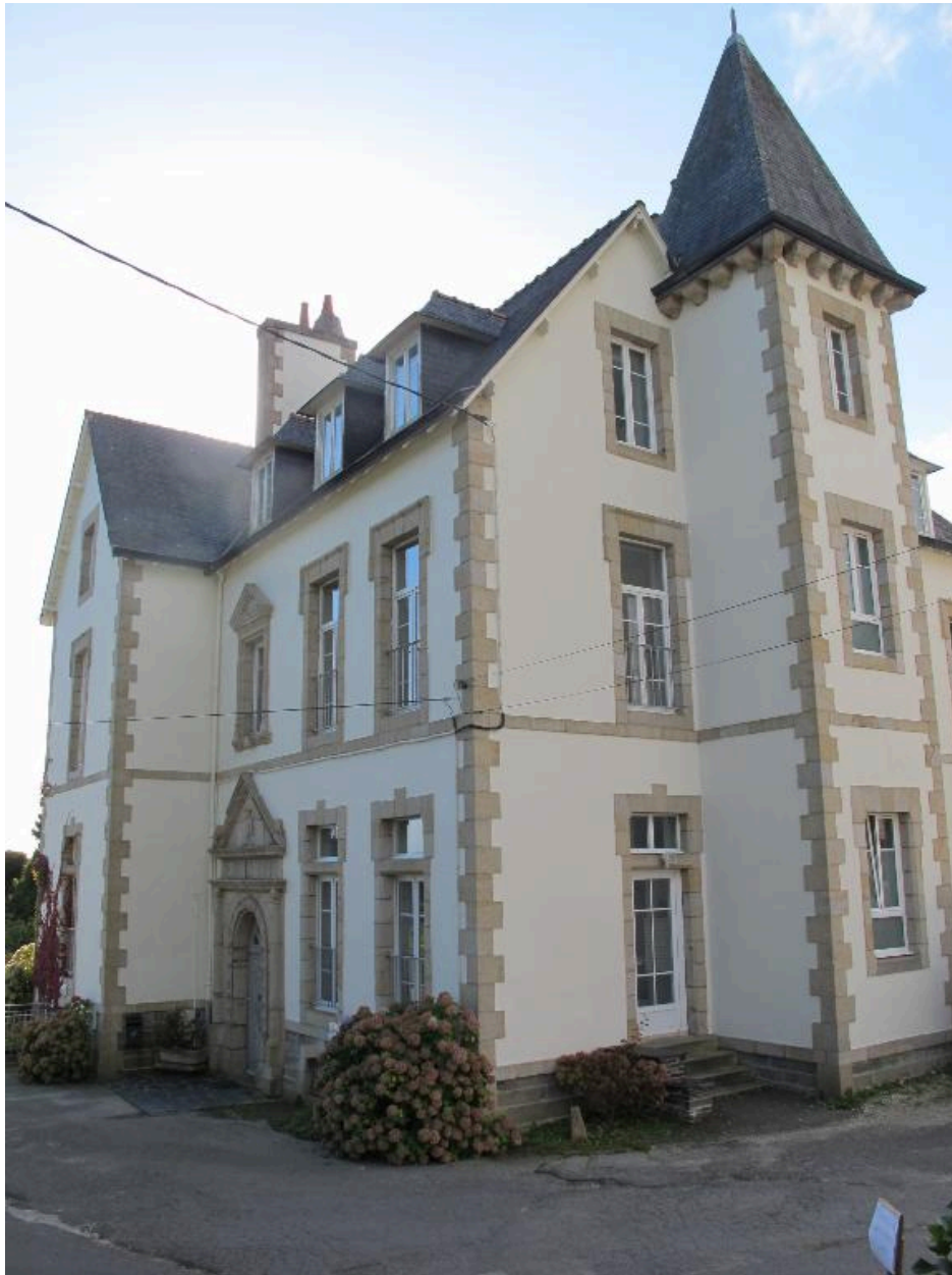
Toul ar c'hoat, façade nord et pignon ouest
