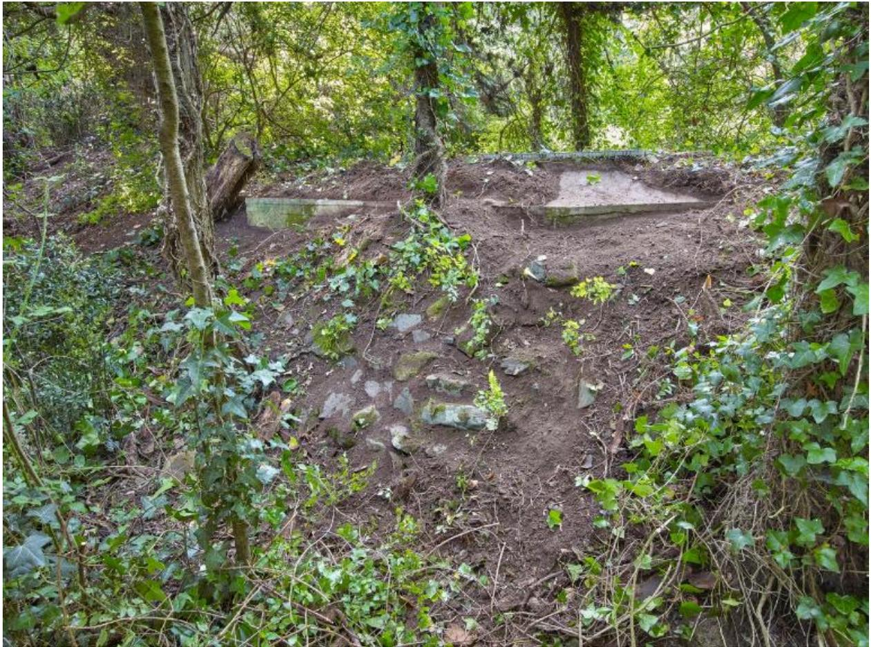
Vue de situation. Le bunker est enchâssé dans un talus constitué d'un mur incliné en pierre sèche
