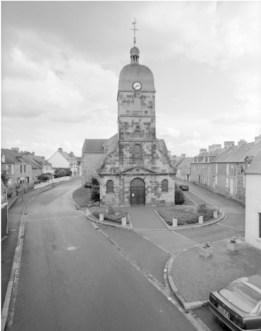
Elévation Ouest : vue générale.
