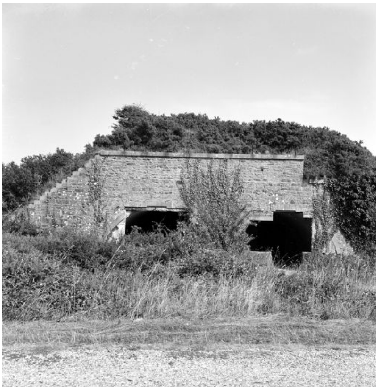
Vue de la batterie de la pointe des Espagnols en 1969 : abri-traverse double de la batterie haute
