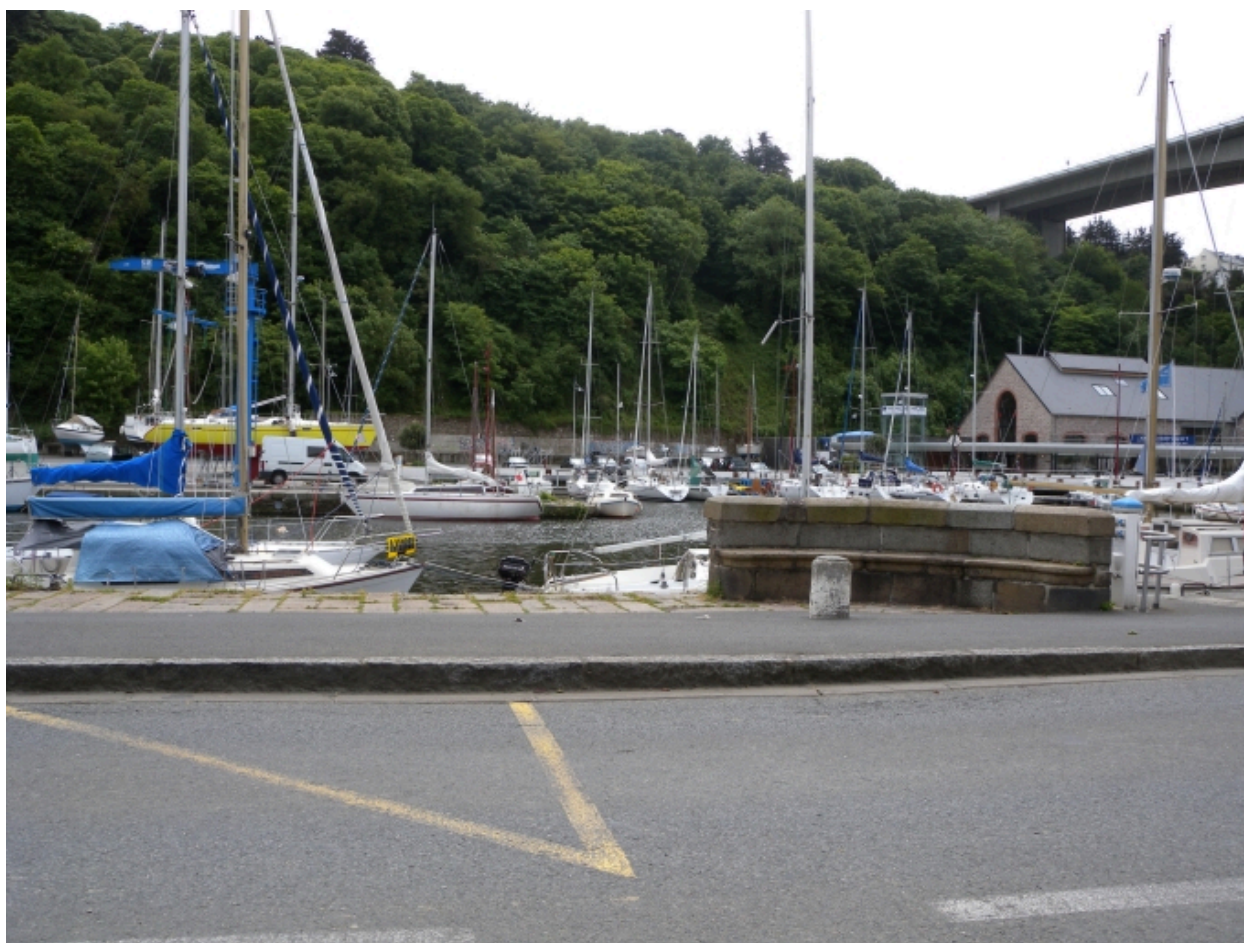
Vue du quai rive gauche du bassin à flot avec le banc traditionnel en pierre
