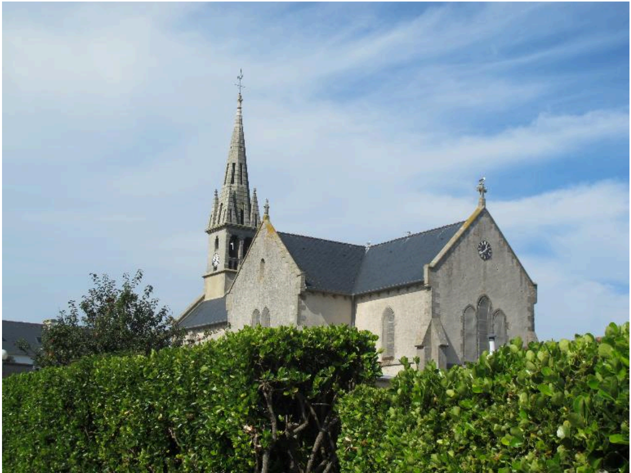
Église paroissiale, élévation sud et chevet
