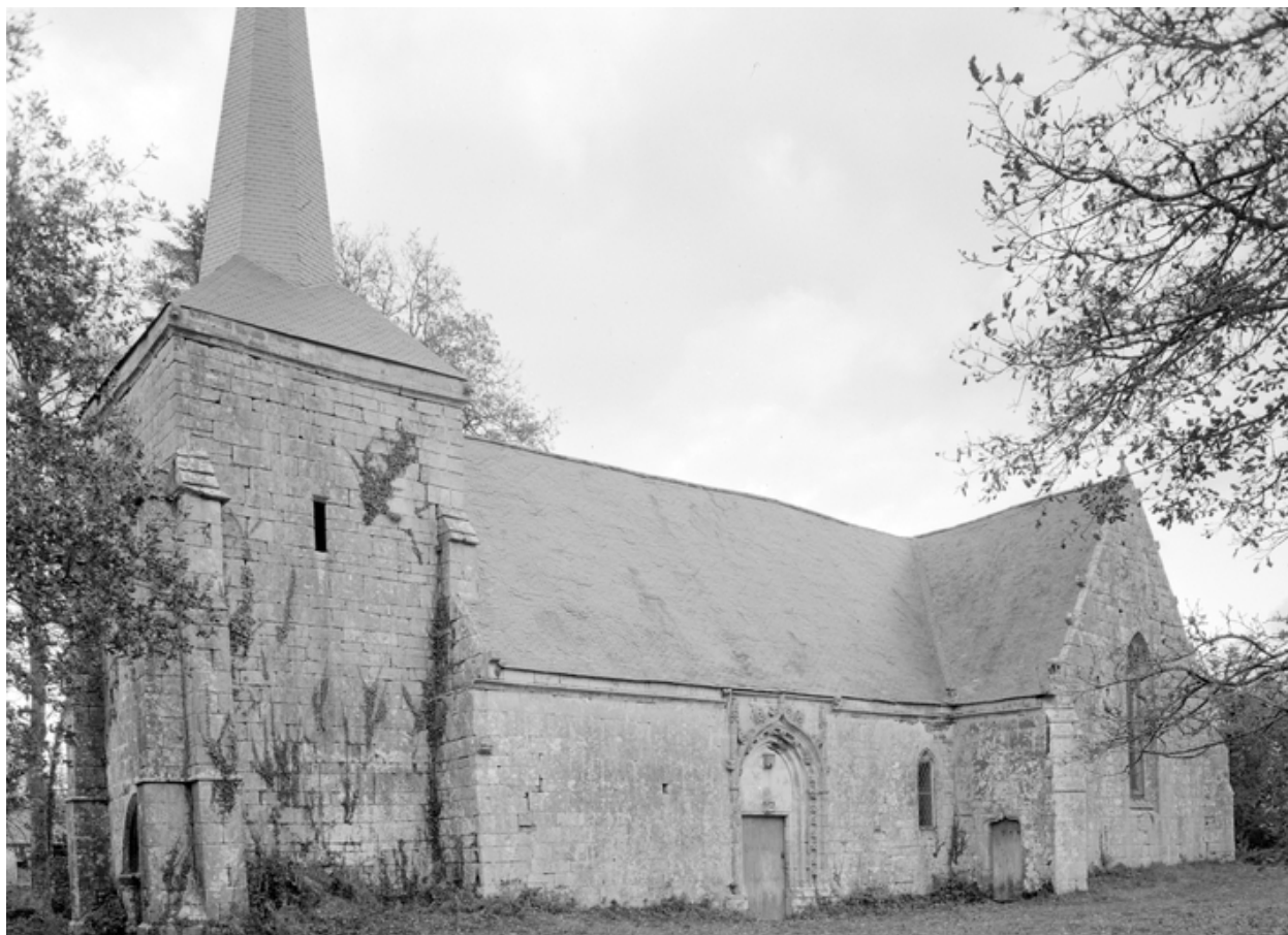
Vue d'ensemble de la façade sud
