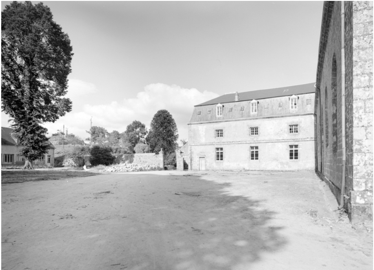
Corps de bâtiment D, aile nord, façade ouest et portail accolé (1965)
