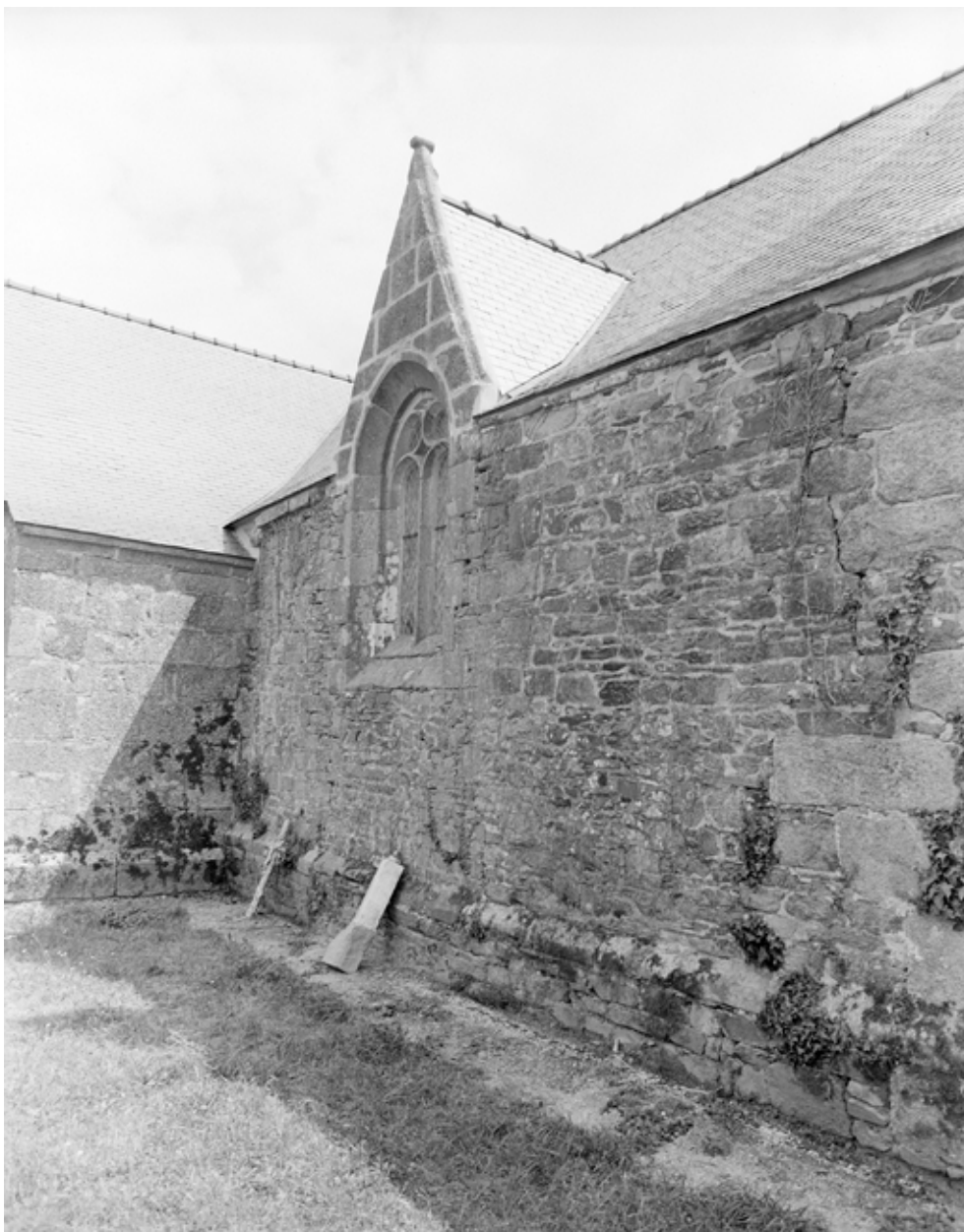
Nef, élévation nord prise du nord ouest
