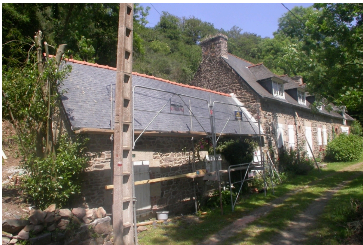
Bâtiments au nord est du site
