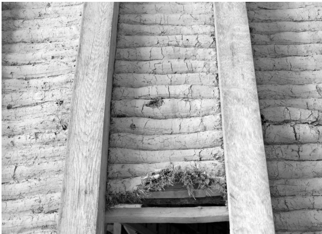
Détail du plafond
