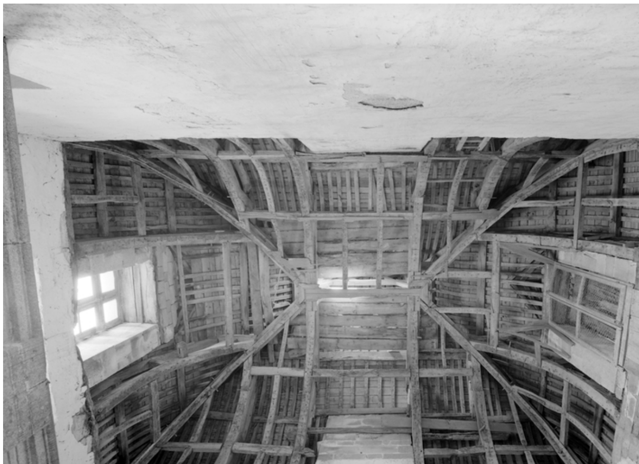
Vue générale de la charpente de la tour, état en 1967
