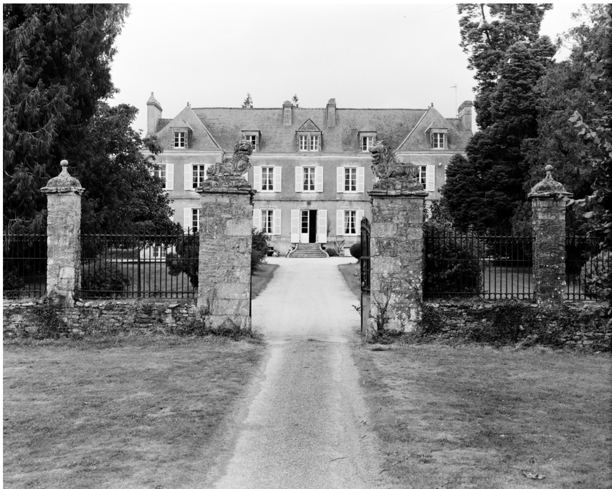
Vue de situation sud avec portail.
