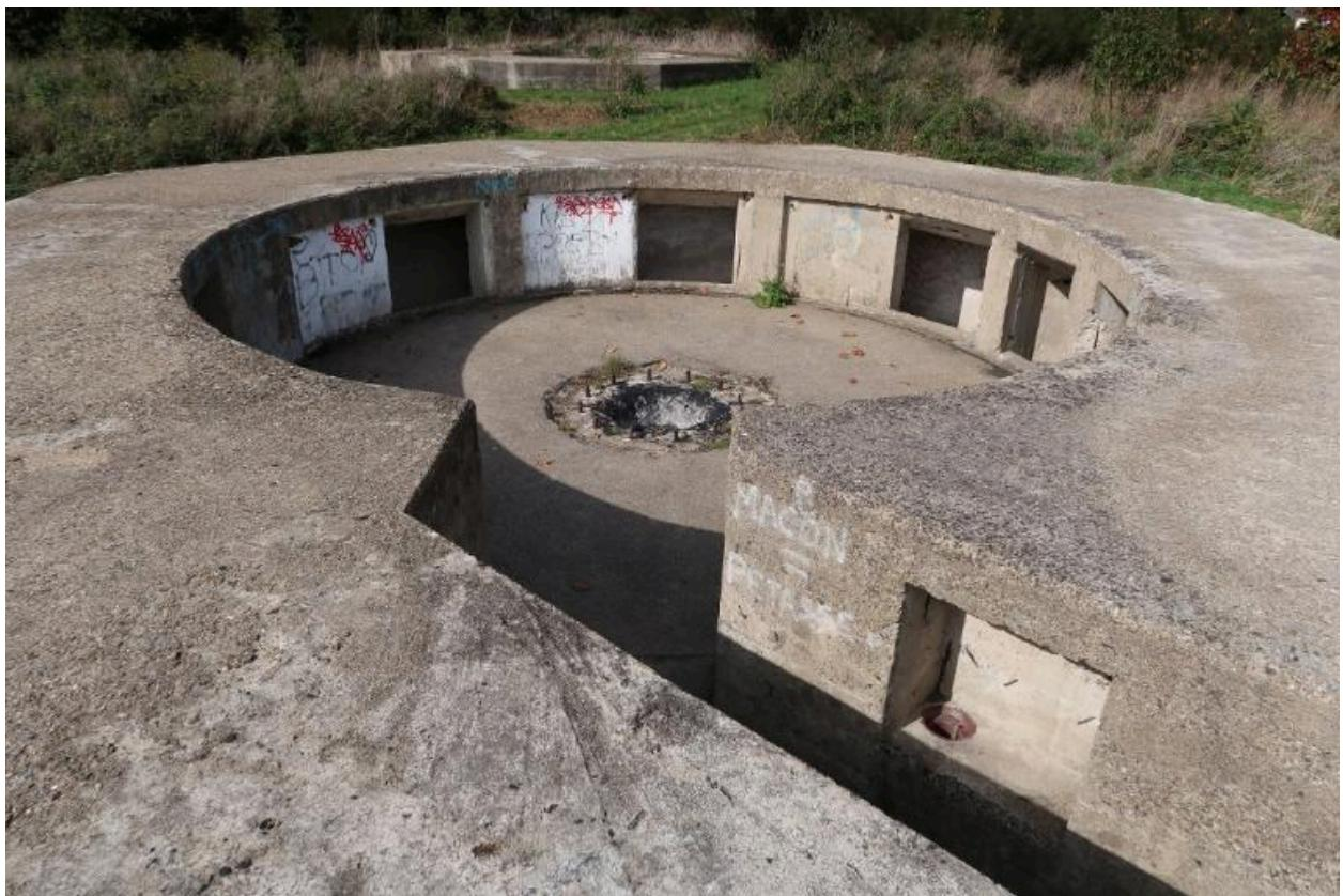
Vue du bunker-cuve de type Fl243a (IV) pour canon antiaérien de 10.5 cm depuis l'est : au premier plan, l'entrée orientée vers l'est ; autour de la cuve circulaire sont implantées sept niches-abris pour les soldats et les munitions ; au centre de la cuve,
