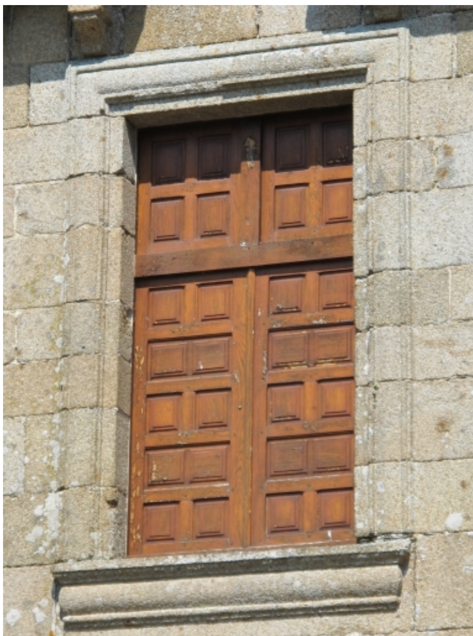
Baie de l'aile nord-ouest
