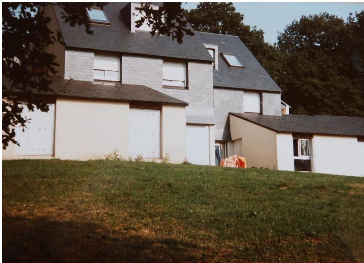
Façades des logements de fonction. Ca. 1980.
