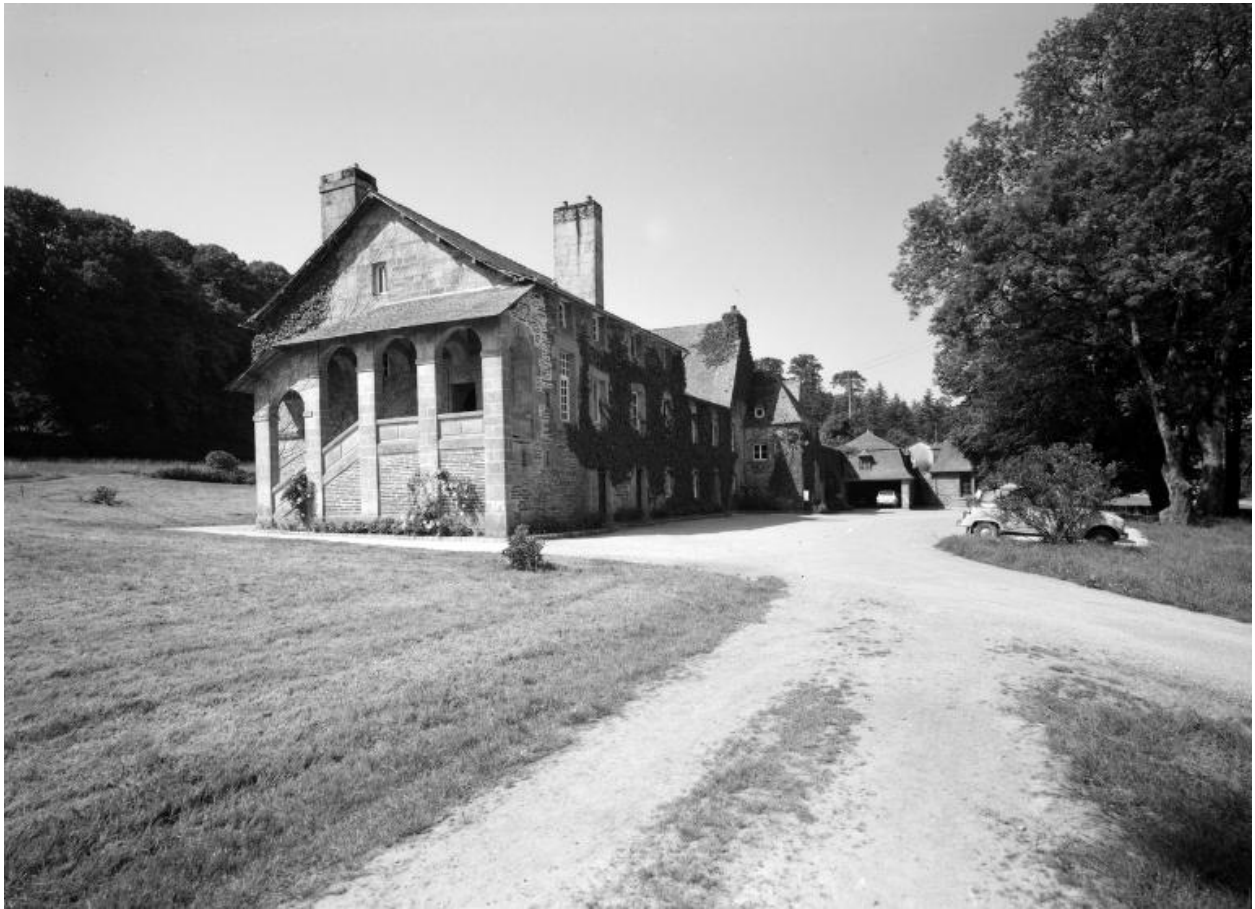
Vue de situation nord-est
