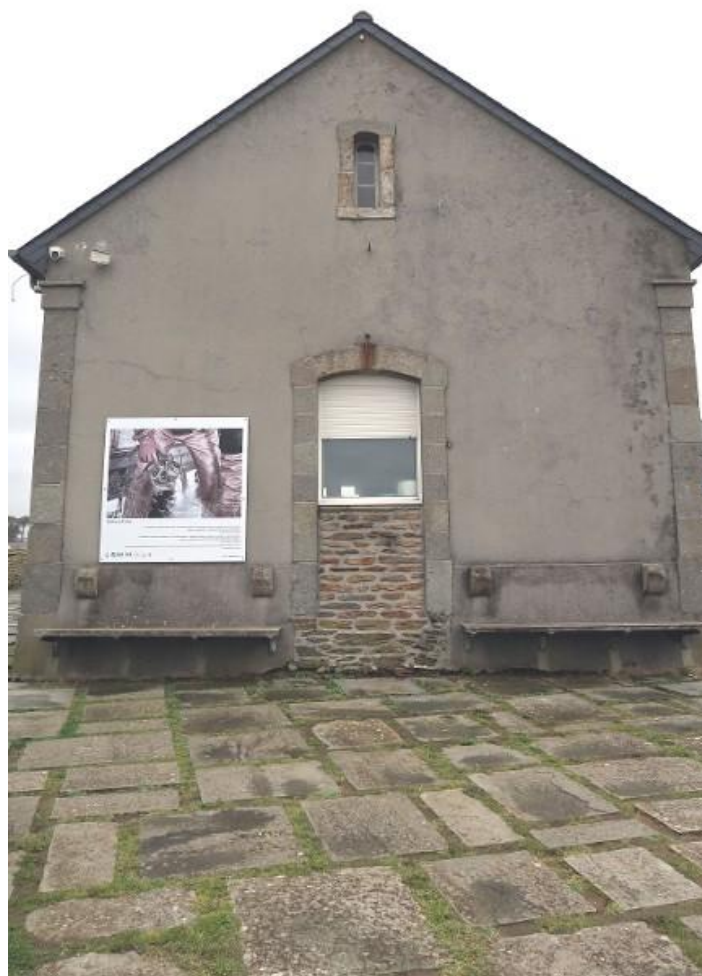
Abri de canot de sauvetage, élévation ouest
