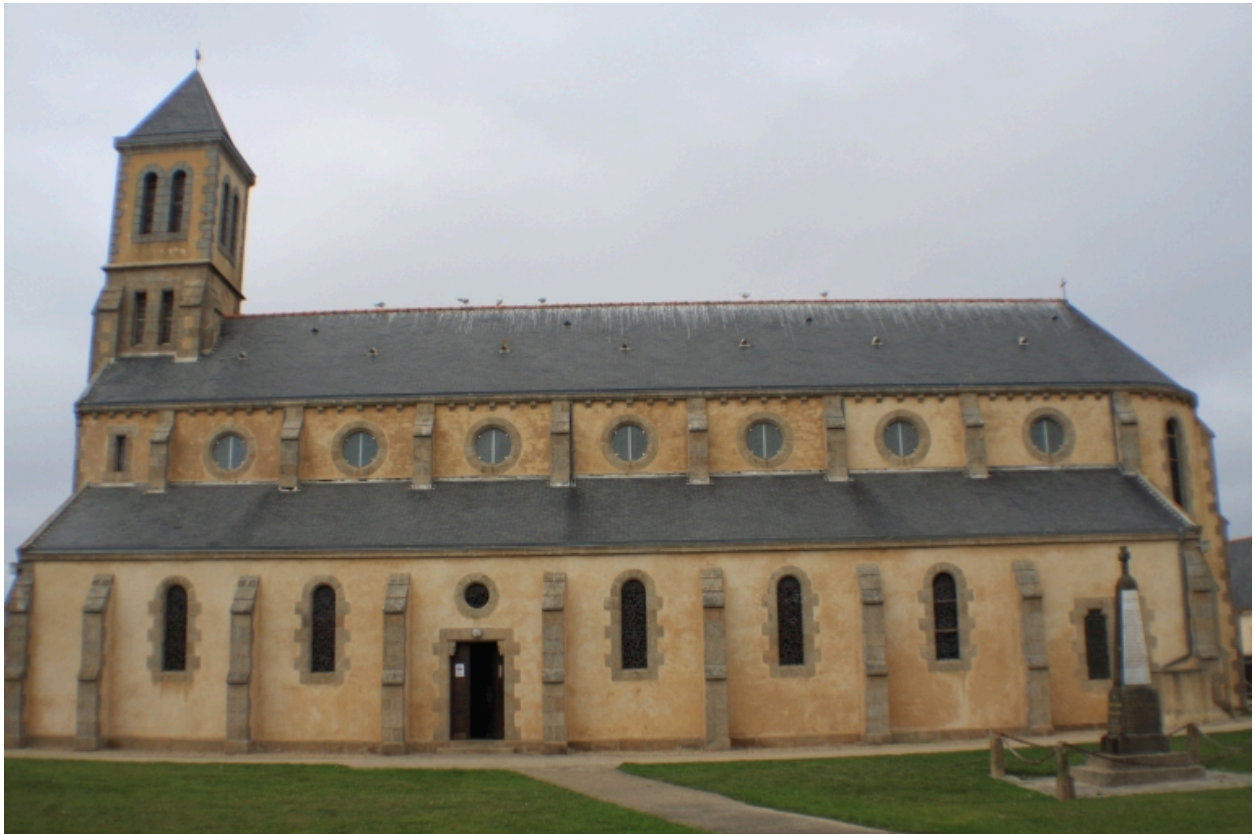
Île-de-Sein, église paroissiale Saint-Guénoilé : élévation sud
