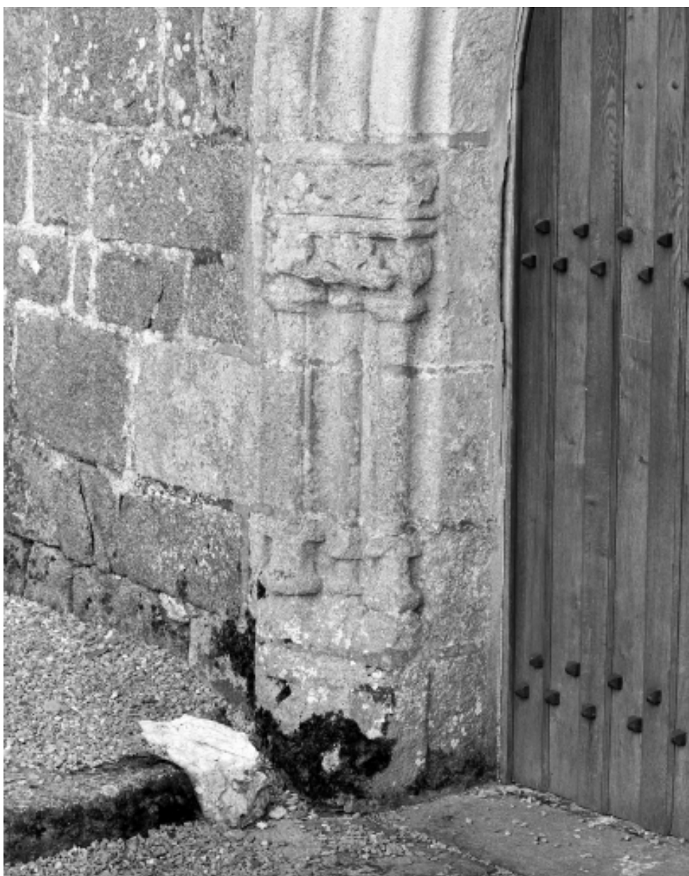
Elévation sud, porte du transept : détail piédroit.
