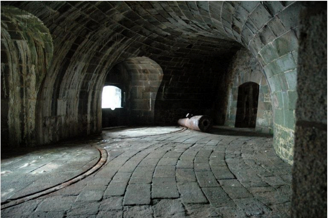
Vue du fort de la Conchée : casemate (n° 2) dit souterrain à deux embrasures. Tube de canon (c) à chargement par la culasse.
