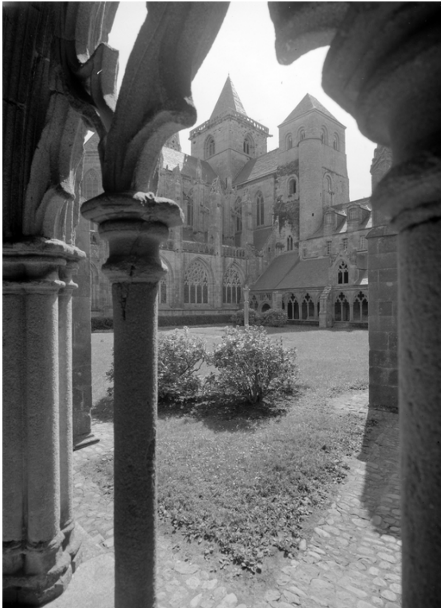
Transept nord et tour Hasting, vue générale à partir d'une arcade du cloître
