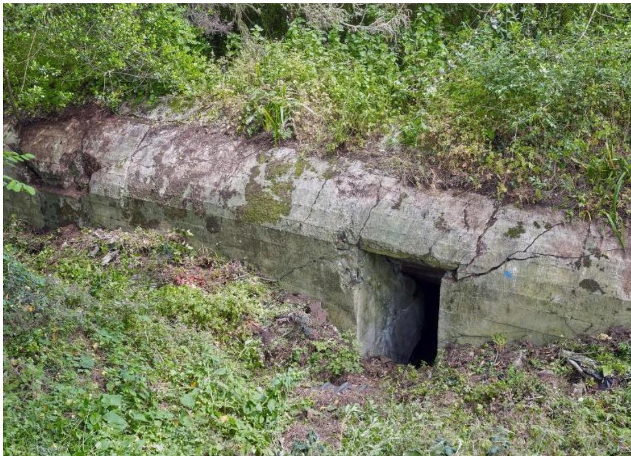
Vue de l'entrée Sud (partiellement murée par des parpaings et remblayée) après débroussaillage. Ce type de bunker est dotée de deux entrées. La tranchée d'accès a été remblayée
