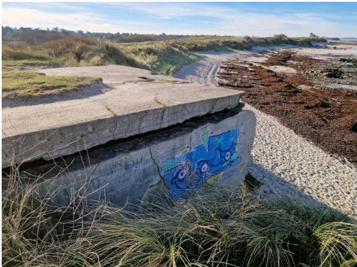
Vue de l'élévation nord. La dalle de couverture du bunker a vraisemblablement été soulevée par l'explosion du magasin aux munitions. En arrière-plan à droite, la grève de Goulven à marée basse
