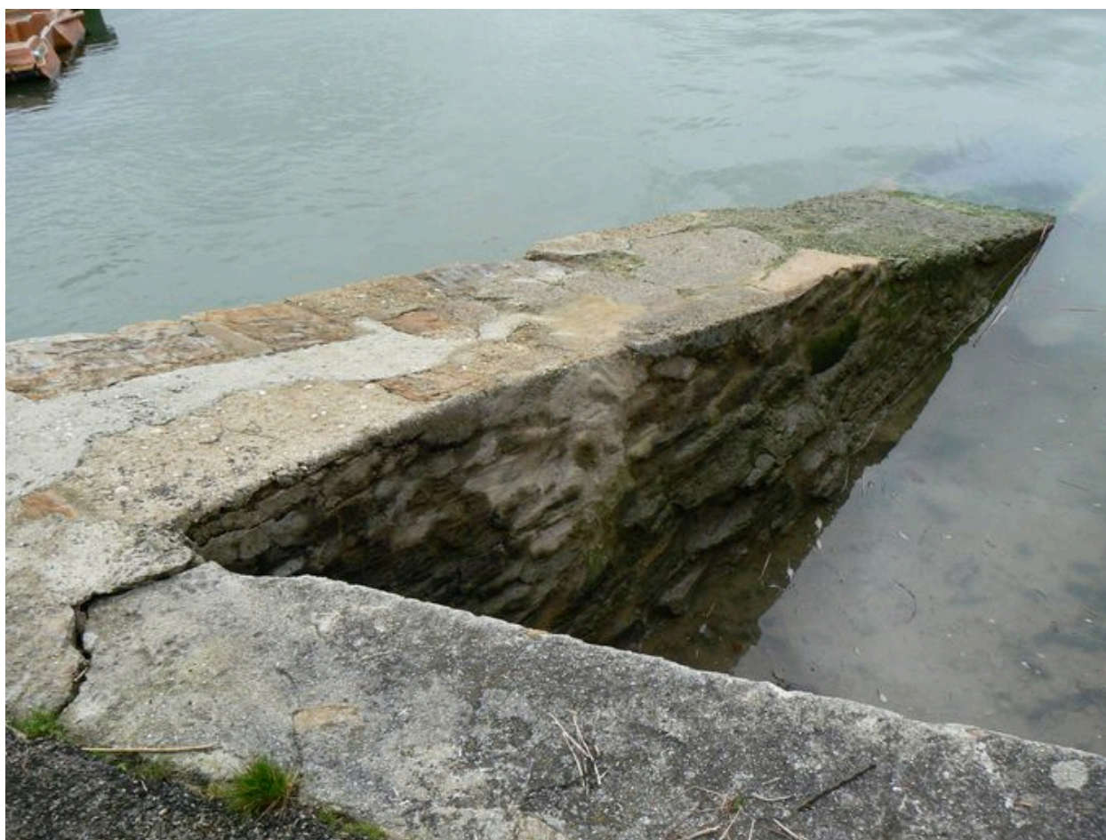
Rampe au bout du quai Polignac
