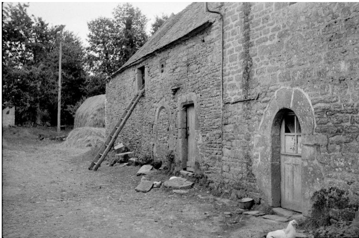
Ferme 1 (état en 1969)
