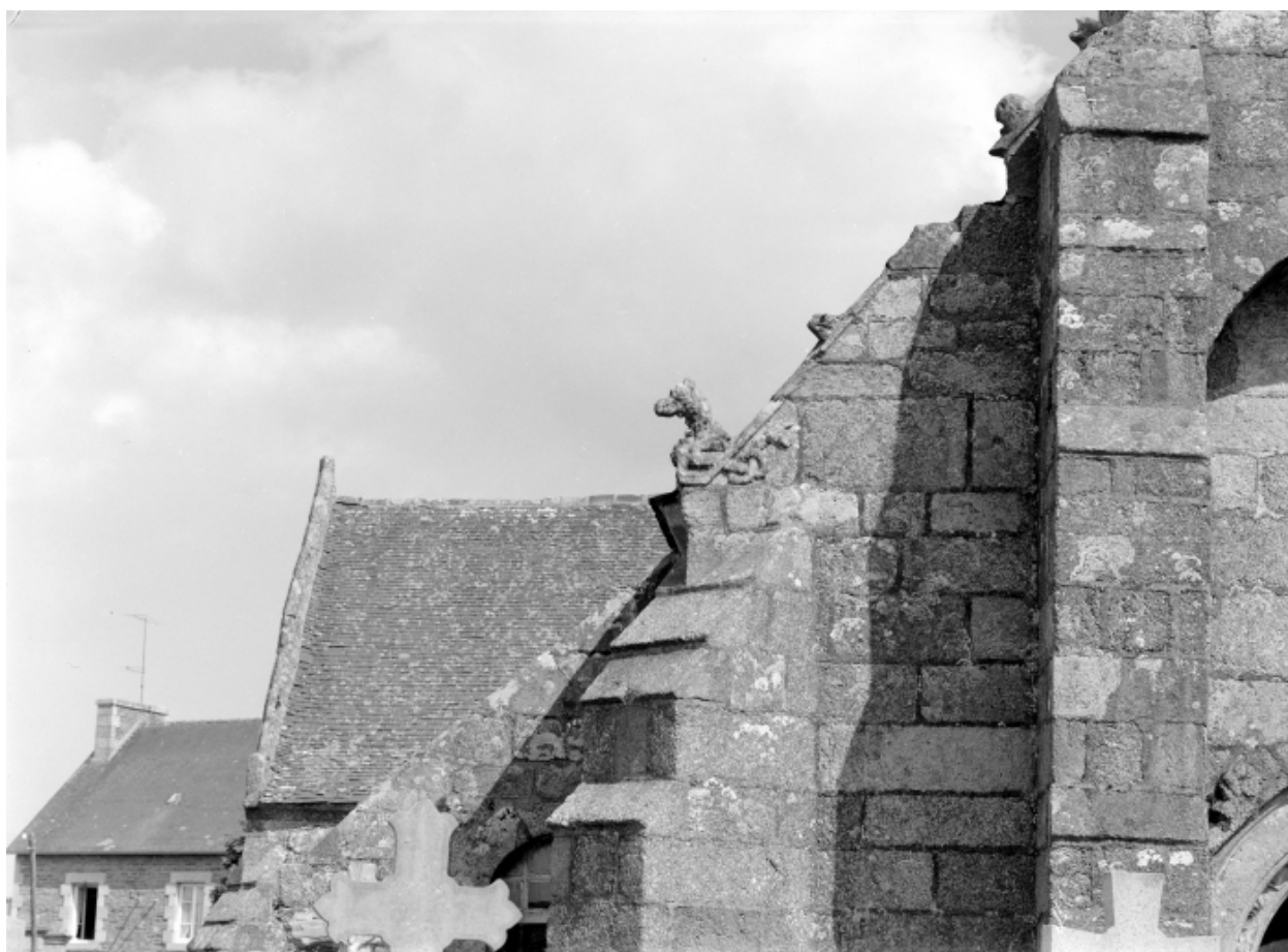
Crossette du rampant gauche du pignon occidental
