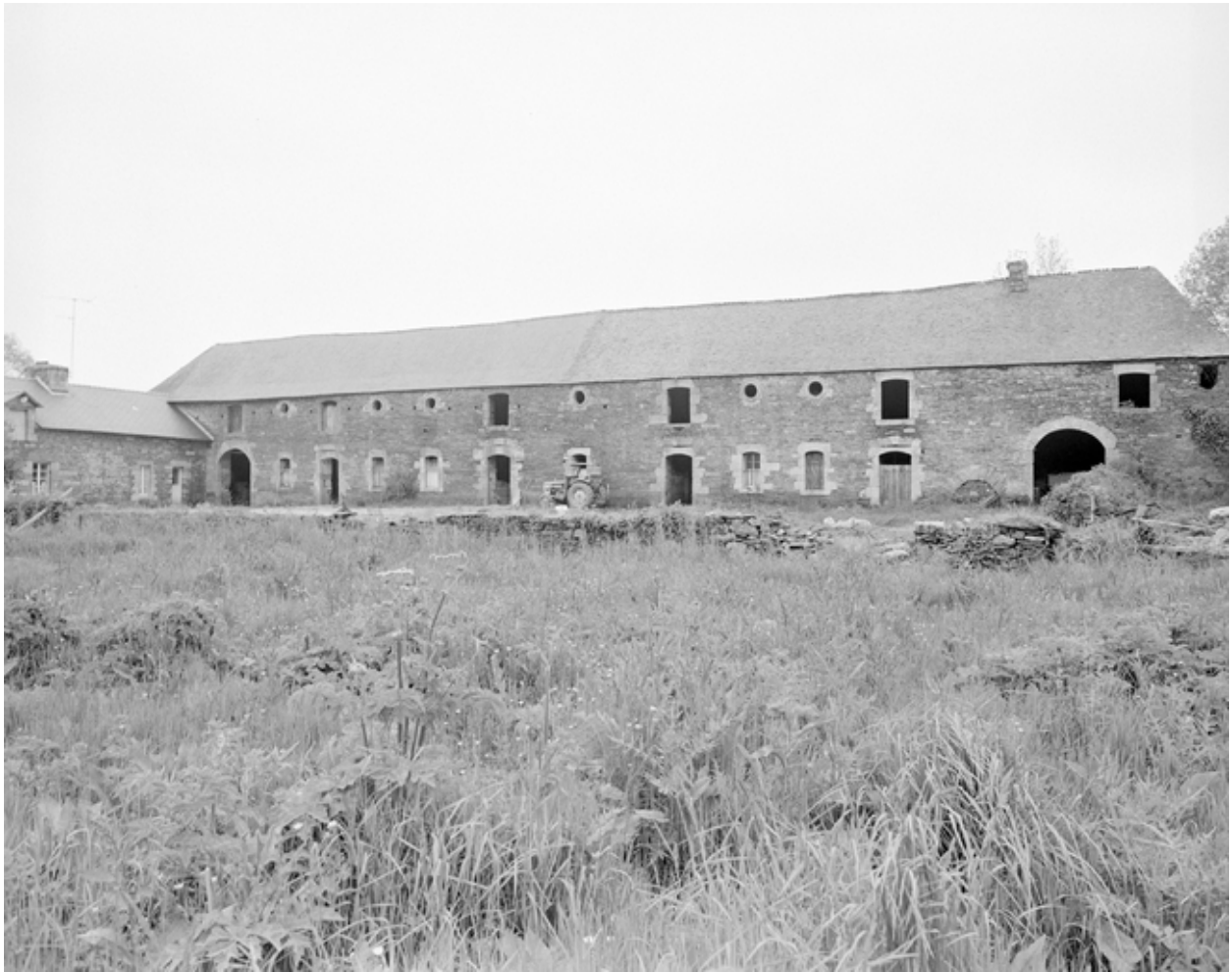
Ecuries, élévation ouest : vue générale (état en 1977).
