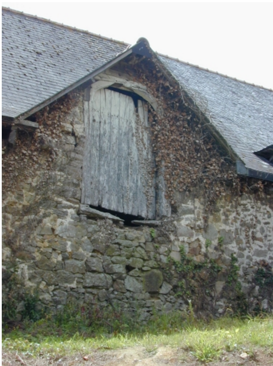
Porte en façade postérieure donnant accès au grenier
