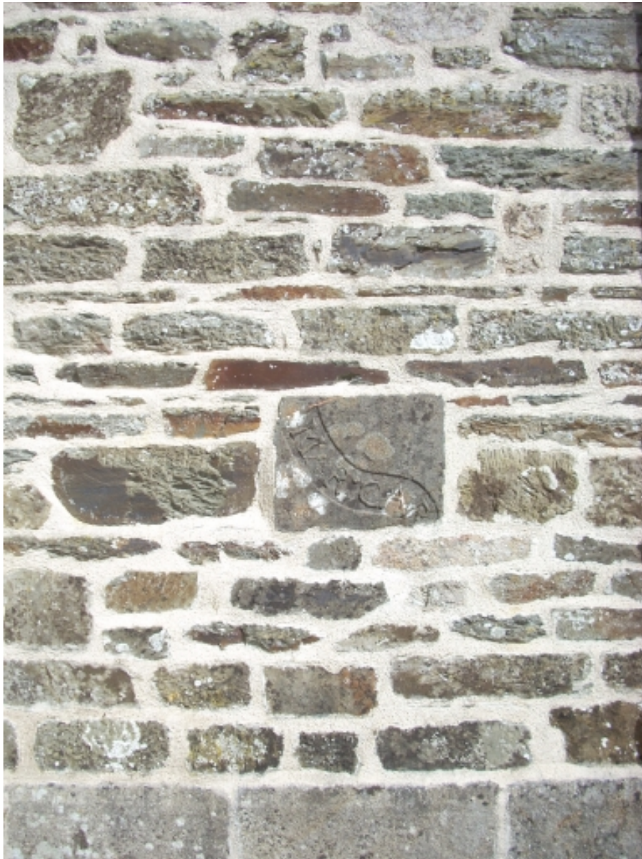
Landeleau, église paroissiale Saint-Théleau : détail du gros oeuvre
