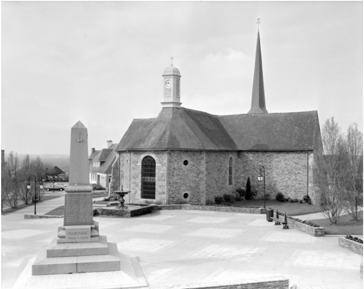
Vue générale est
