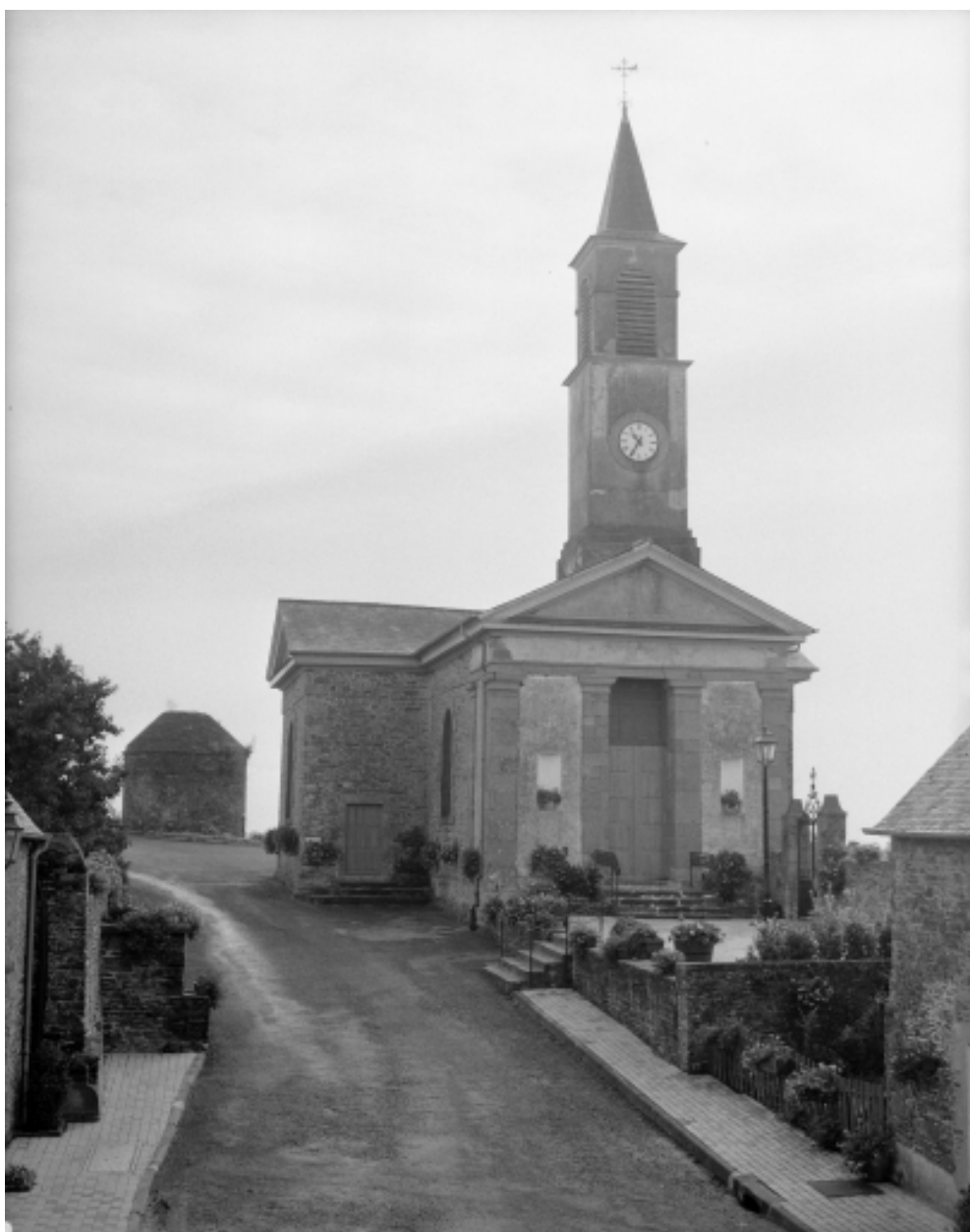
Elévation Ouest : vue générale
