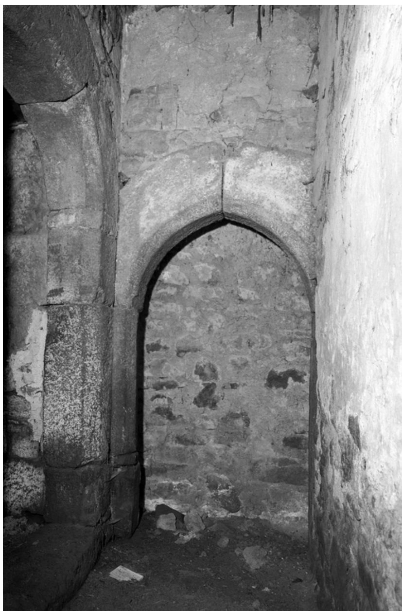
Rez-de-chaussée, couloir nord (porte à l'extrémité est)
