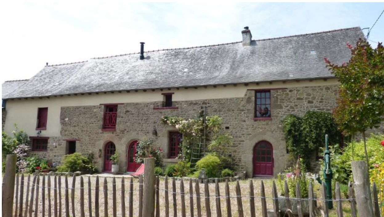
Vue de la façade principale orientée est
