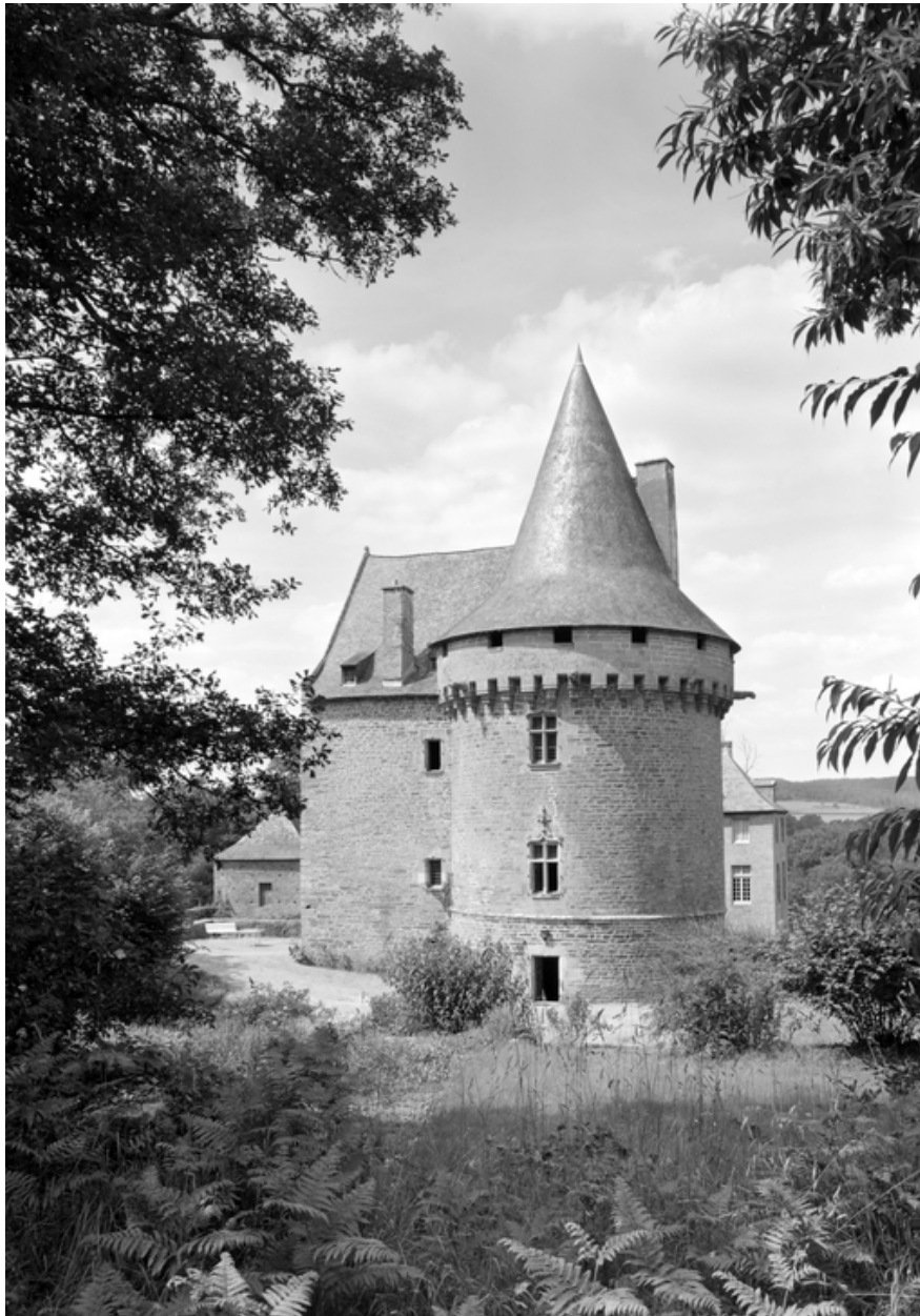
Tour sud : vue générale prise du sud (état en 1984)
