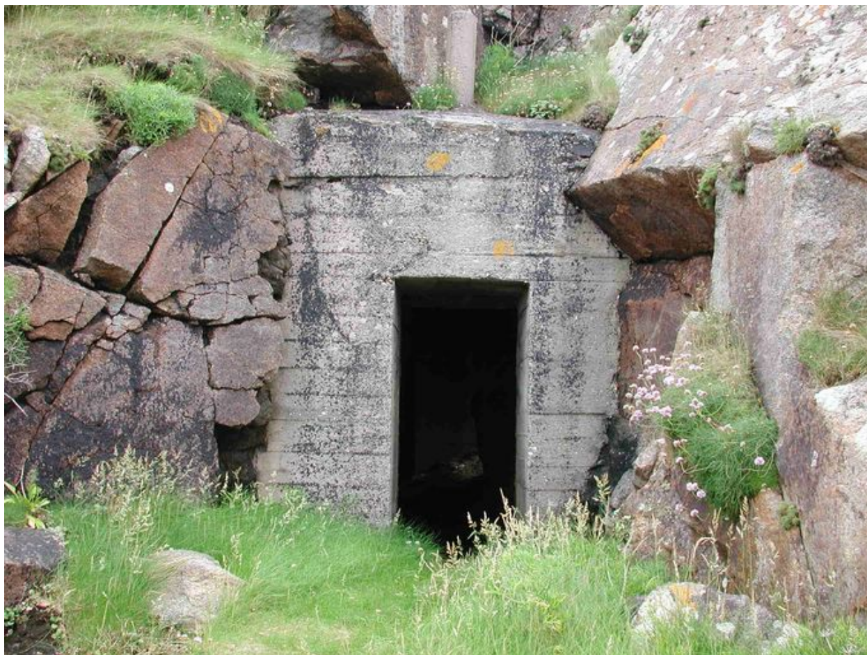
Accès à la cale depuis le tunnel
