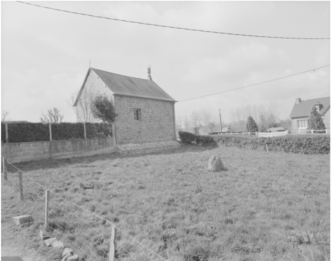
Elévation Nord-Est : vue générale
