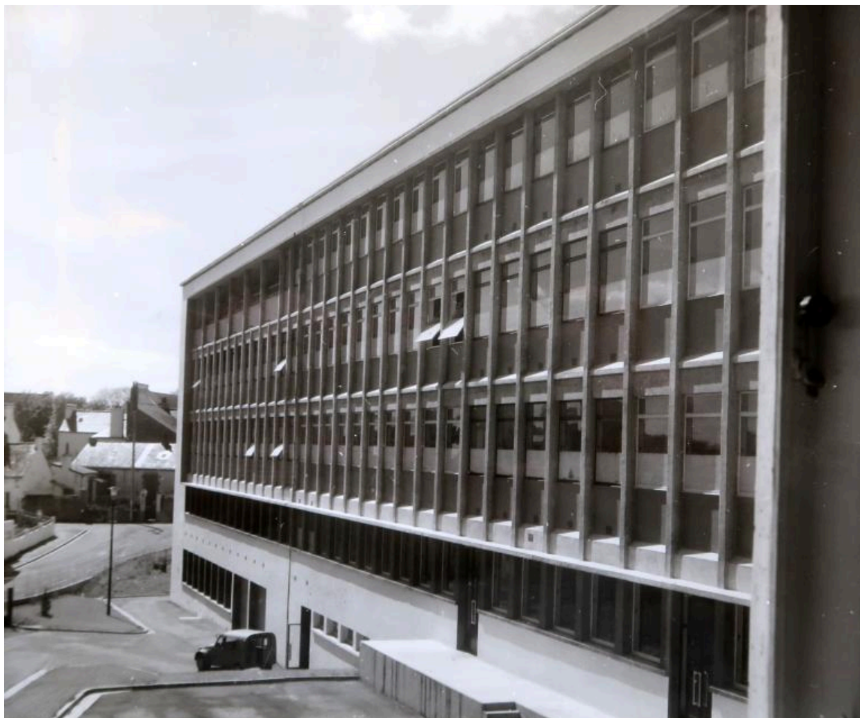
Façade arrière du bâtiment B.
